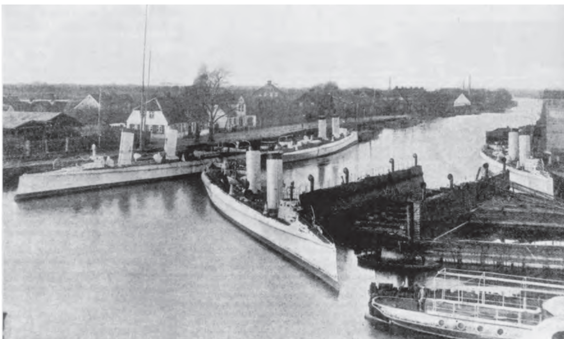
Les quatre torpilleurs chinois dans les chantiers de Schichau à Elbing en Allemagne.
