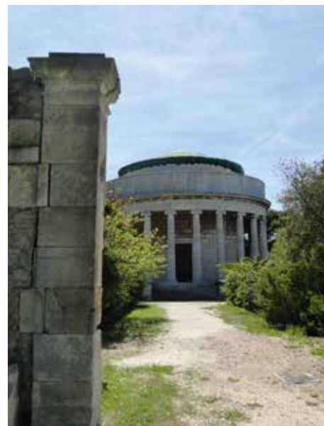
La couverture provisoire de la chapelle attend son remplacement par une restauration prochaine. Photo BC.
