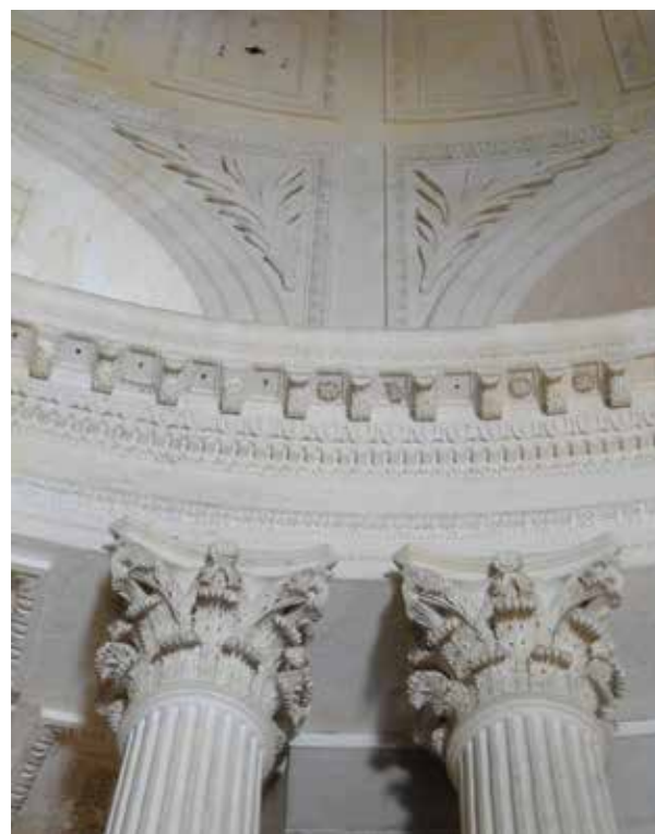
Détail de l'entablement corinthien et de la coupole. Photo BC.
